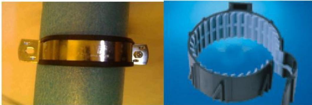
Colonna di scarico rivestita con collare antivibrante
