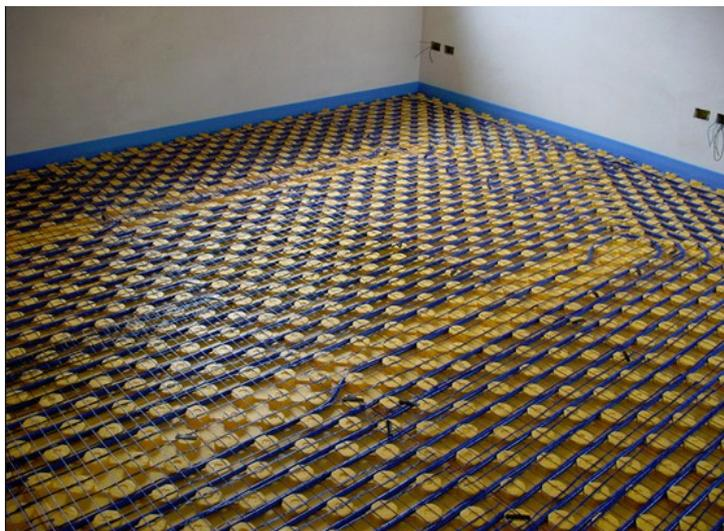
L'impianto di riscaldamento è a pavimento. Le cucine sono dotate di presa per induzione elettromagnetica che assicura il massimo rendimento e la minore dispersione del calore. Gli attacchi per lavatrici sono dotati oltre che di attacco acqua fredda anche di presa di acqua calda per ridurre al minimo lo spreco energetico in fase di carico. La climatizzazione estiva è garantita da split ad aria fresca.
