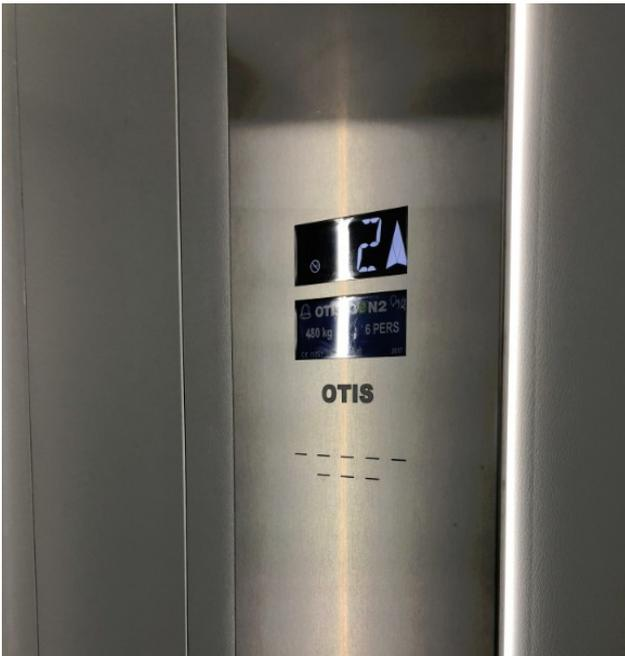
Ascensore per n.6 persone, portata kg 480 min. della ditta OTIS mod. Gen2 comfort, funzionamento elettrico **a basso consumo < 3Kw**. Caratteristiche di base:
